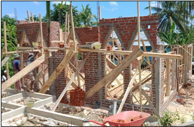
Gambar 5. Fundasi dan Tahapan Pembangunan Dinding Bata
