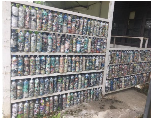
Gambar 2. Pemanfaatan ecobrick sebagai dinding
